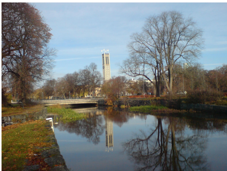
Figur 9: Utsikt norrut från järnvägsbron över Svartån
